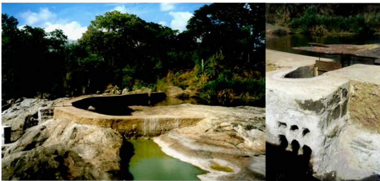
Foto 1: Barragem com betão e sistema de comportas
